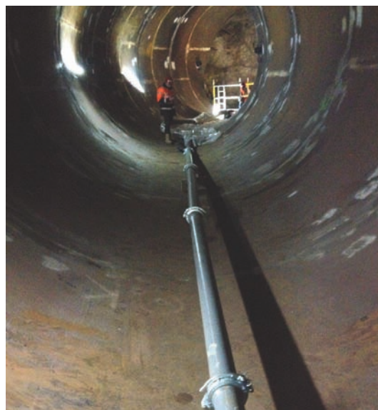
Pompage sur 120 ML pour injection du béton autoplaçant par guillotine avec contrôle des pressions d'injections.
